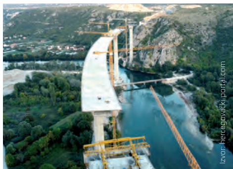
Radovi na mostu Počitelj iznad Neretve, najvećim i najimpozantnijim mostom na Koridoru 5C duljine 980 m i visine 100 m
